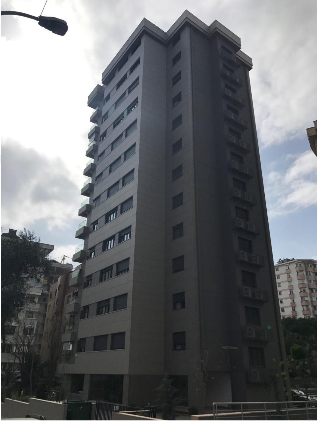
Şekil 6.11: Erenköy Kasvetli Koyu Renk Bina Örneği 468
