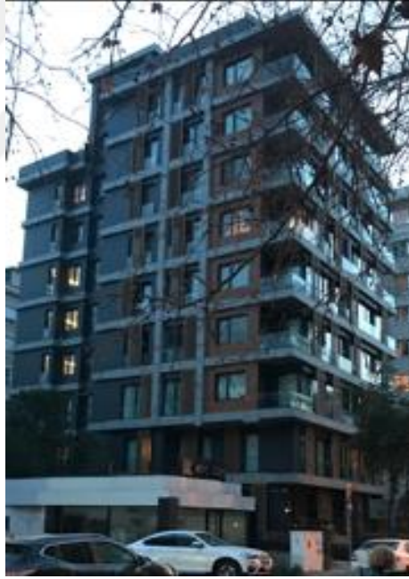
Şekil 6.4: Erenköy’de Bir Apartman: Dış Yüzeyde Hareketli Panel Örneği 405
