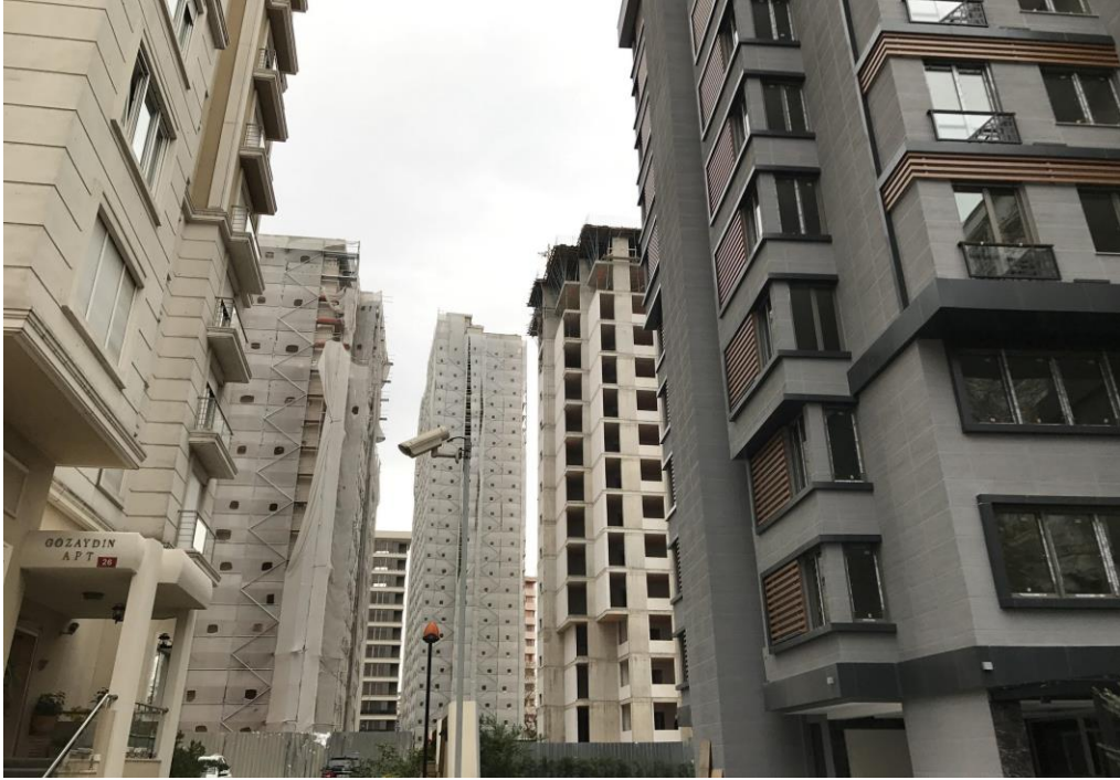
Şekil 6.9: Caddebostan’da Çok Yüksek Katlı Binalardan Oluşan Sokak Dokusu 466
