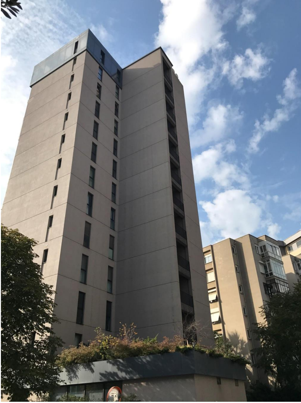
Şekil 6.12: Feneryolu’nda Dar Pencereci Apartman Örneği 469
