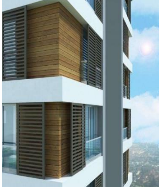
Şekil 6.3: Göztepe’de Çınar Apartmanı: Hareketli Gölge Panelleri Örneği 404
