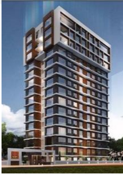
Şekil 6.8: Bostancı’da Bir Apartman: Çıkma Örneği 410
